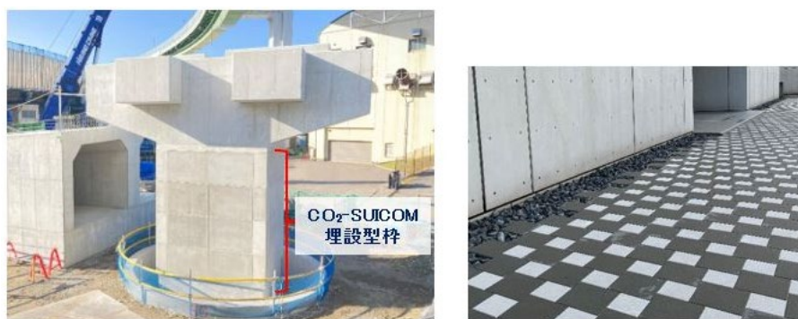
図 1-3-1 「CO 2 -SUICOM」の埋設型枠と舗装ブロック
