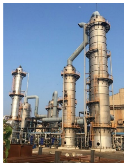
図 18. CCSL 社の設備
