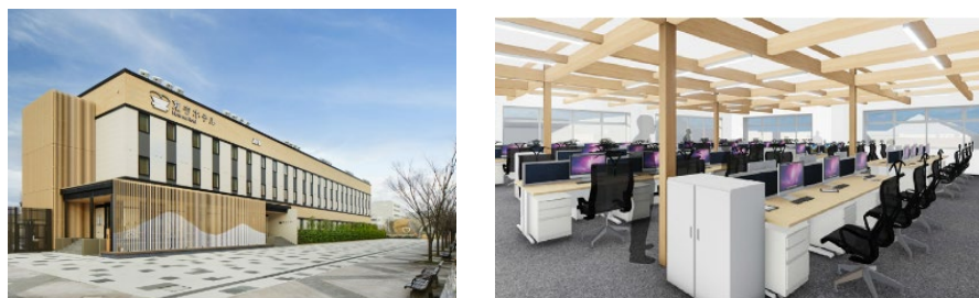
図 27. 左；東亜建設の高い木造技術を生かして建築されたホテル
