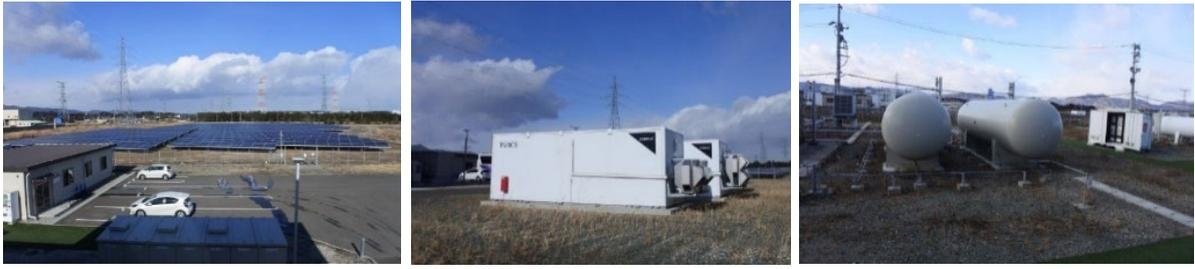
図 14. SIGC で運用する設備；左から太陽光発電、蓄電池システム、水素タンク
